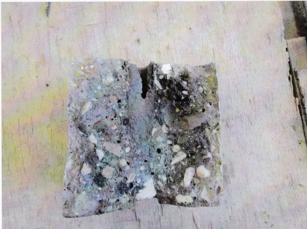
Bild 2: Probekörper 1 nach der Prüfung
